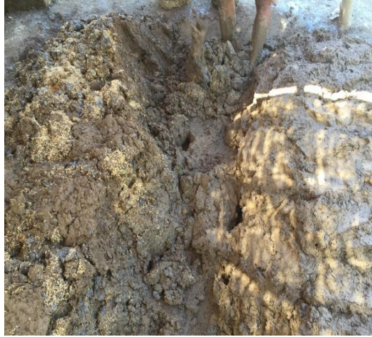
Gambar 4. Bancuhan tanah liat, air dan sekam padi secara manual.
